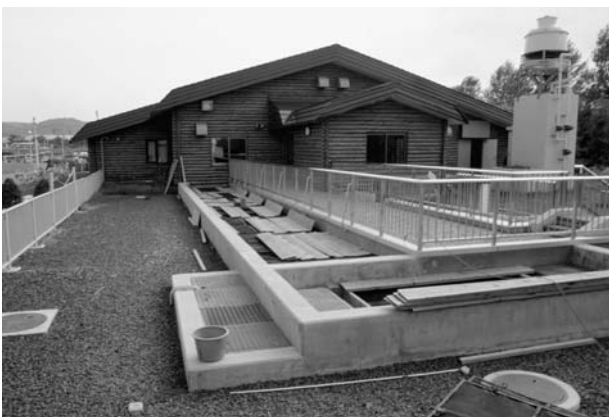
写真1 1986年のさけ科学館。写真右の白い円形の塔が、前年から稼働しているクーリングタワー
